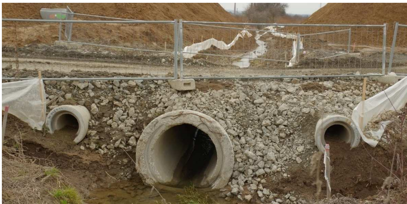
Obrázek 20: Příklad křížení vodoteče s provizorní přístupovou komunikací – propustky pro suchou a mokrou cestu v kombinaci s dočasnými naváděcími zábranami. Dálnice D1, úsek 0137.
